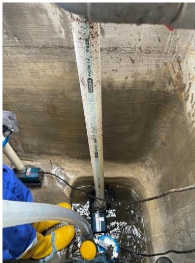
Gambar Kondisi saat pembersihan chamber
